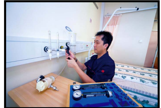
喉管式醫療氣體供應系統 (Medical Gas Pipeline System)
